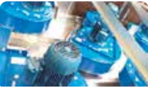
Вакуумные вентиляторы в чистой зоне на базе двигателей Siemens
