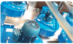
Вакуумные вентиляторы в чистой зоне на базе двигателей INNOMOTICS
