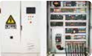
Шкаф управления на базе комплектующих Schneider Electric
