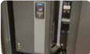
Отдельный шкаф блока частотной регулировки с охлаждением
